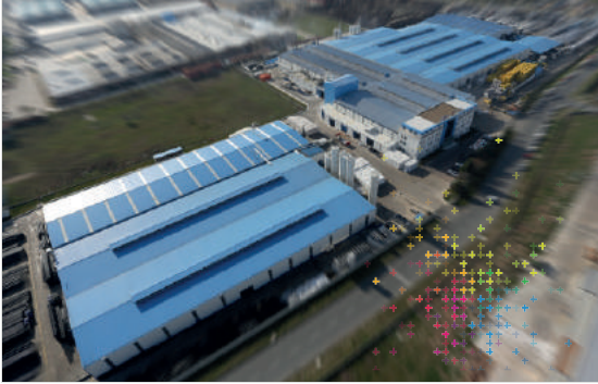
Georg Fischer Hakan Plastik Çerkezköy Üretim Tesisleri
